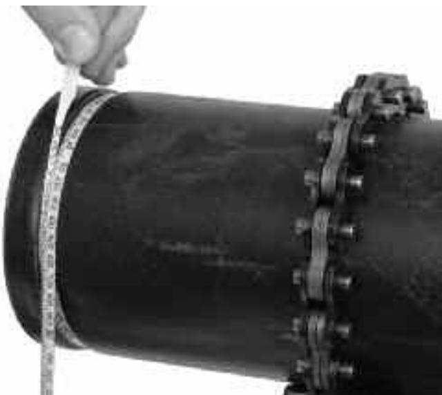
**Рисунок 11 – Проверка диаметра желобка с помощью измерительной ленты**
